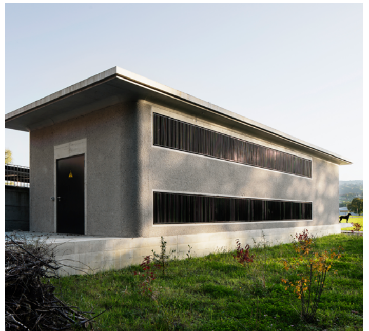
Oben: Pavillion und Trafostation (Neubauten)
