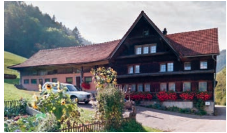
Baugesuch: Abbruch bestehendes Bauernhaus mit Stickerei
