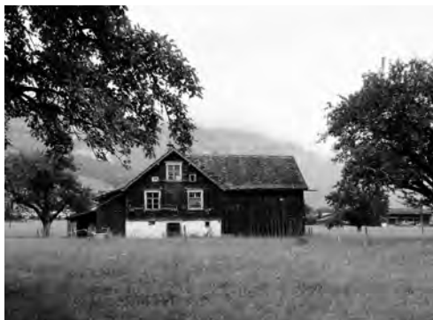
Beispiel Abbruchobjekt Rheintal
