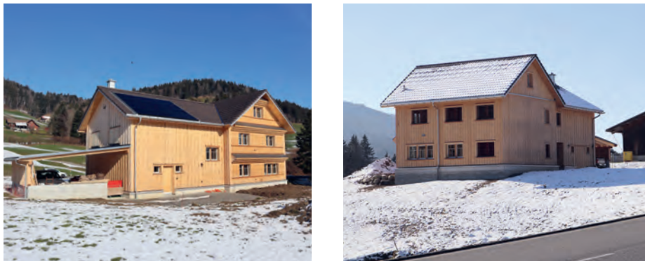
Ersatzbau an der Strasse von Wattwil Richtung Ricken
