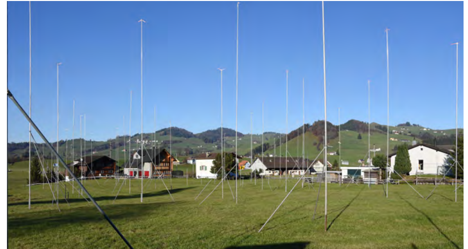
Visiere Überbauung Enggenhüttenstrasse, dahinter neues Gewerbe- und Industriegebiet «hintere Rüti» (grosse Scheune) (Bild: Hansueli Gantenbein, «Appenzeller Volksfreund»)
